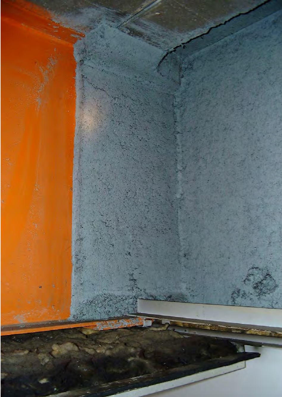
Abbildung 14 Spritzasbest (hier Blauasbest) diente dem Brandschutz, dem Kondenswasserschutz und der Akustik.
