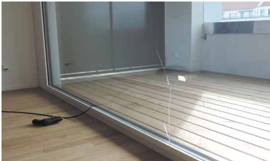
Typische Schadensbilder an grossen Fensterscheiben, verursacht durch teilweise Beschattung und Hitzestau.
