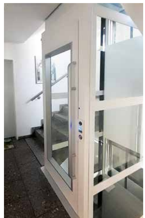
Nach dem Einbau des Liftes und der Handläufe
